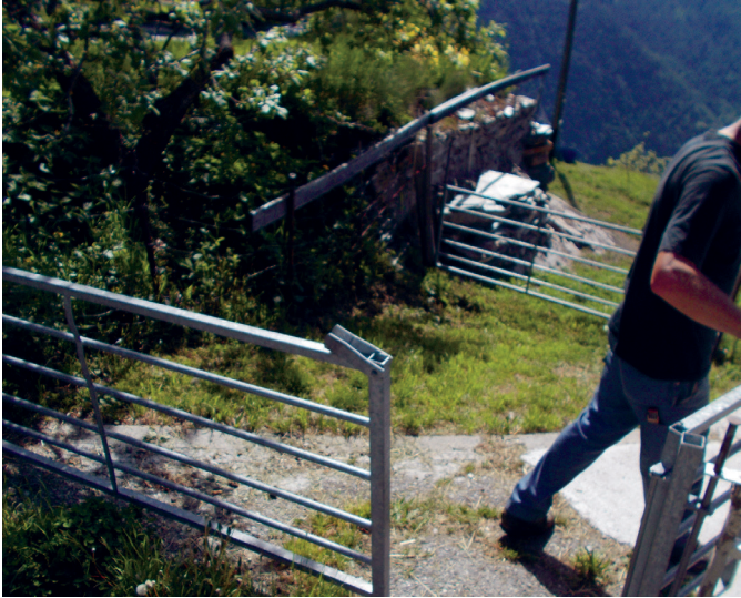
Abb. 3 Nicht-elektrifiziertes Tor in einem ansonsten gut aufgebauten Zaun. (Foto: AGRIDEA)
