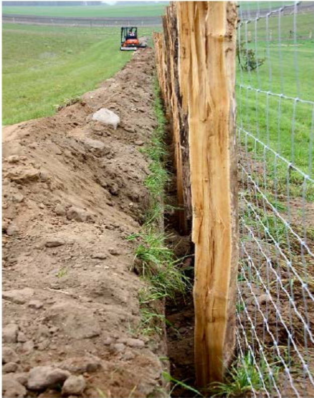
Zaun vor Auffüllung des Grabens
