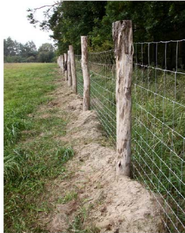
Fertig gestellter Zaun
